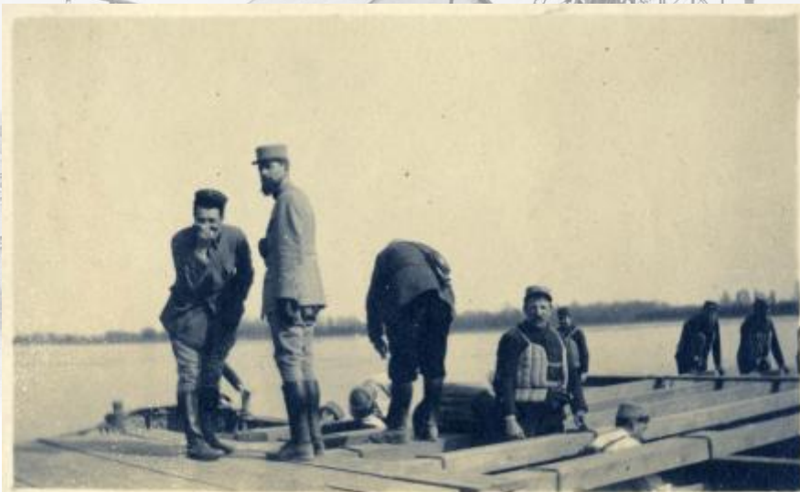
Référence : D125-6-8 Angers, Maine-et-Loire. Exercice de pontage sur la Loire - dépôt du Génie. Février à mai 1916.
