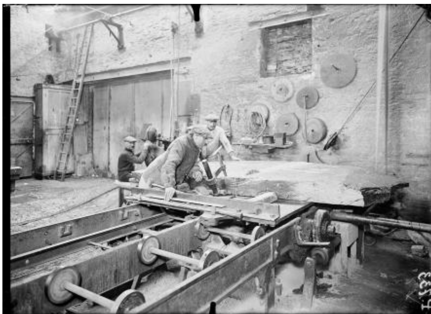
Référence : SPA 69 P 733 Trélazé, Maine-et-Loire. Les procédés d'extraction, de taille et de polissage des ardoises destinées à la construction des maisons à la compagnie des ardoisières de l'Anjou. 10 au 20 décembre 1916.
