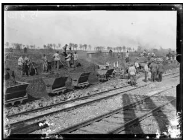
Référence : SPA 30 IS 1245 À Banvillars (Territoire de Belfort) des soldats italiens construisent et entretiennent les voies ferrées. 13 mars 1918. Photographe : Bressolles/© ECPAD
